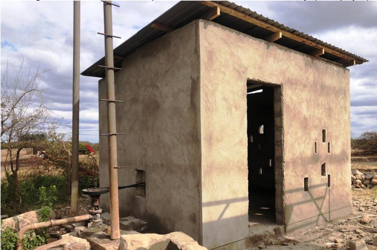
Abbildung 12: Fertig erstelltes Pumpenhaus in Olekitejo mit erneut installiertem Dieselgenerator
