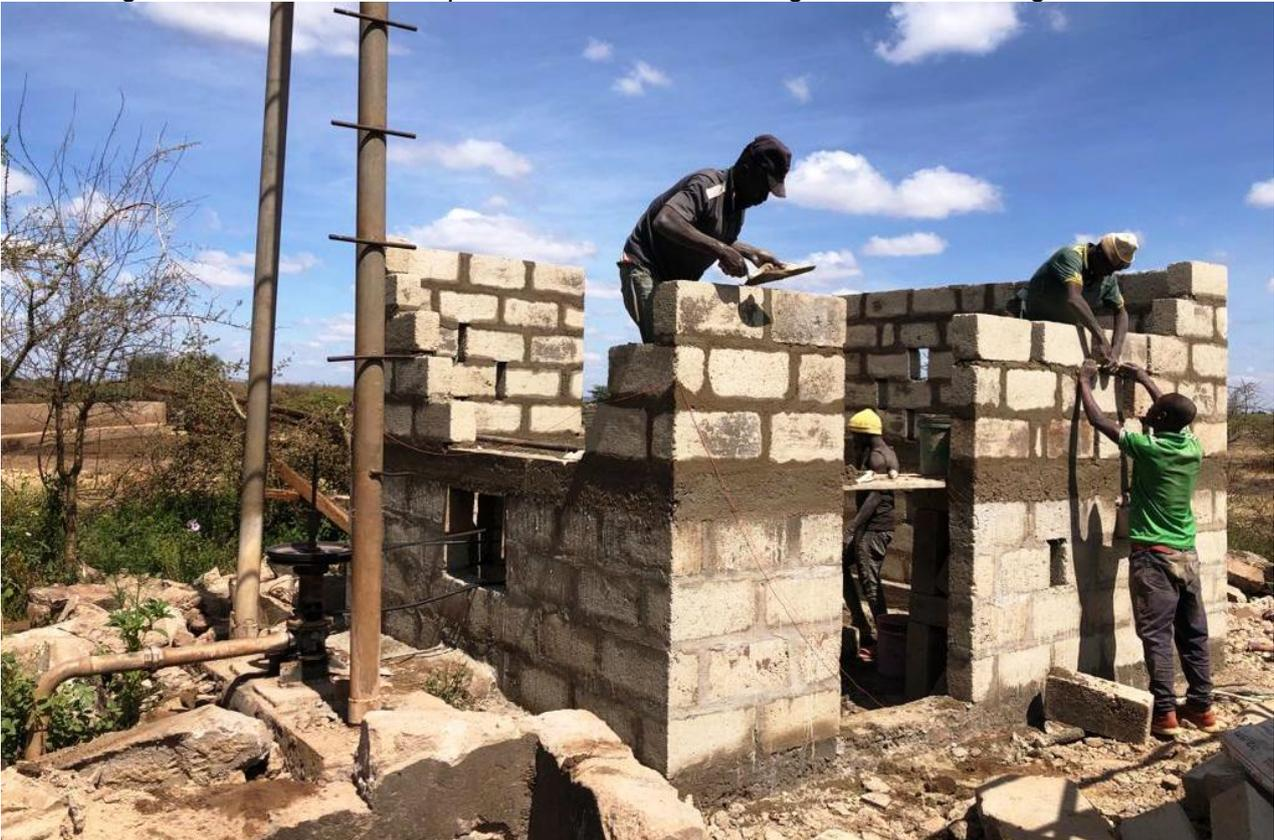
Abbildung 11: Rohbau des neuen Pumpenhauses an der Viehtränke in Olekitejo (2. Teilprojekt)
