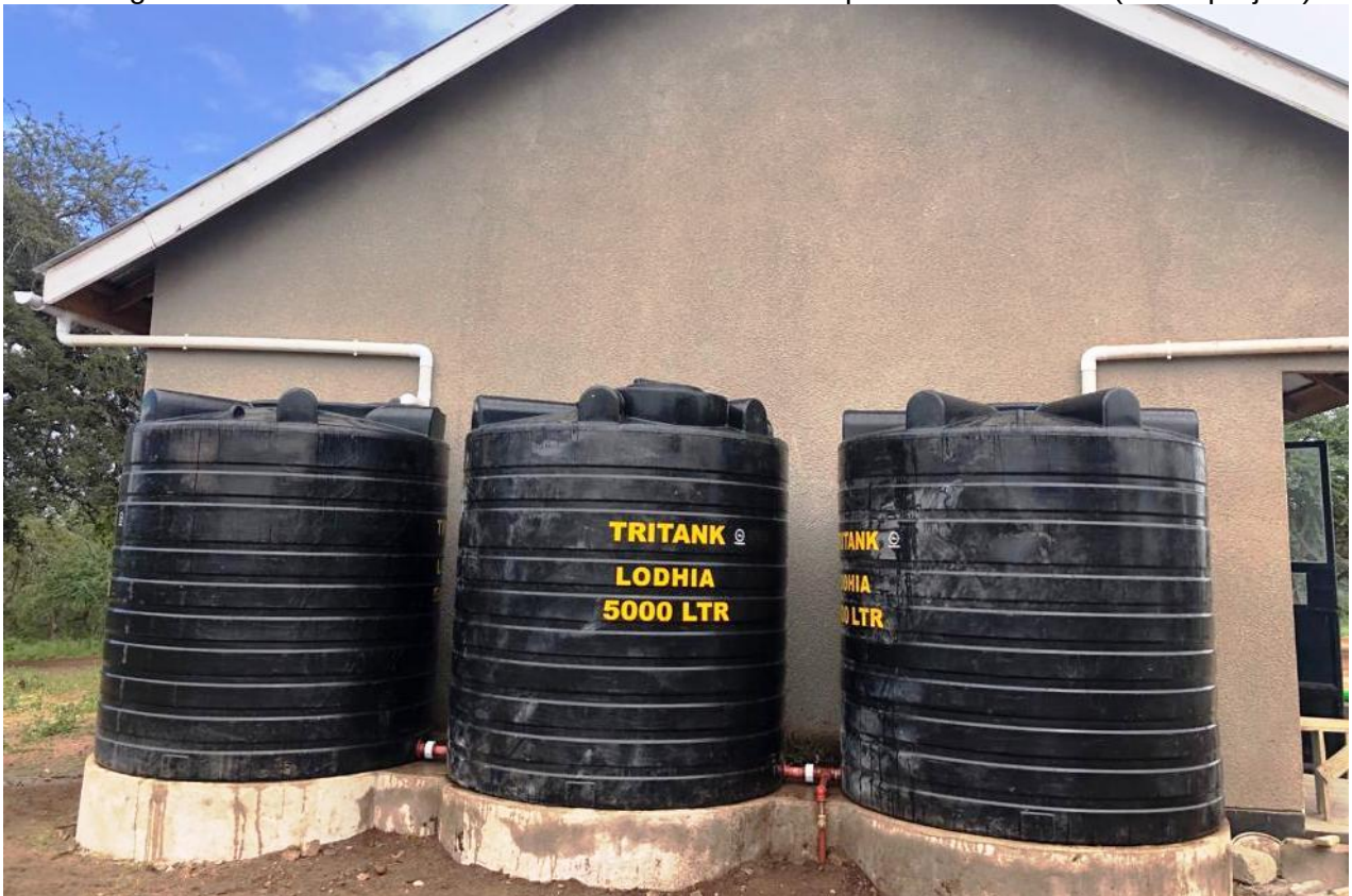
Abbildung 30: Wassertanks an Schule in Osilalei auf Zementpodesten installiert (2. Teilprojekt)
