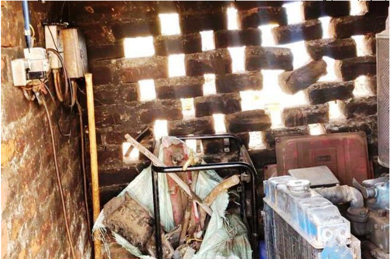
Abbildung 2: Technikraum mit Generator bei Brunnen in Nyorrit war sehr baufällig (1. Teilprojekt)
