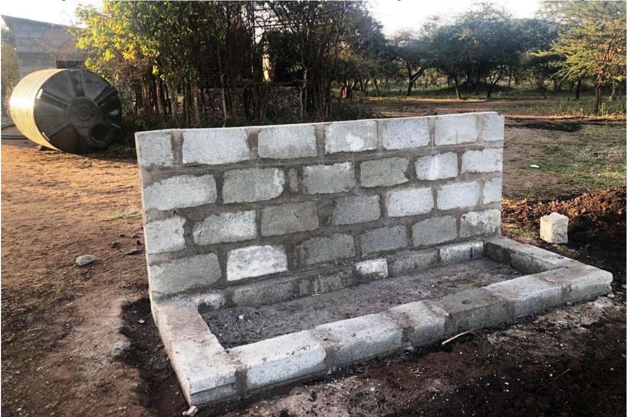
Abbildung 22: Neue Trinkwasser-Bezugstation in Nyorrit mit 6 zusätzlichen Wasserhähnen
