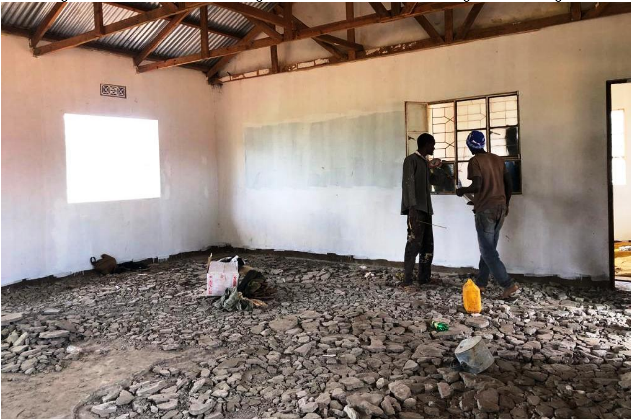
Abbildung 8: Alte Fussböden der Schulgebäude Mbuko bei Renovierungsstart herausgebrochen
