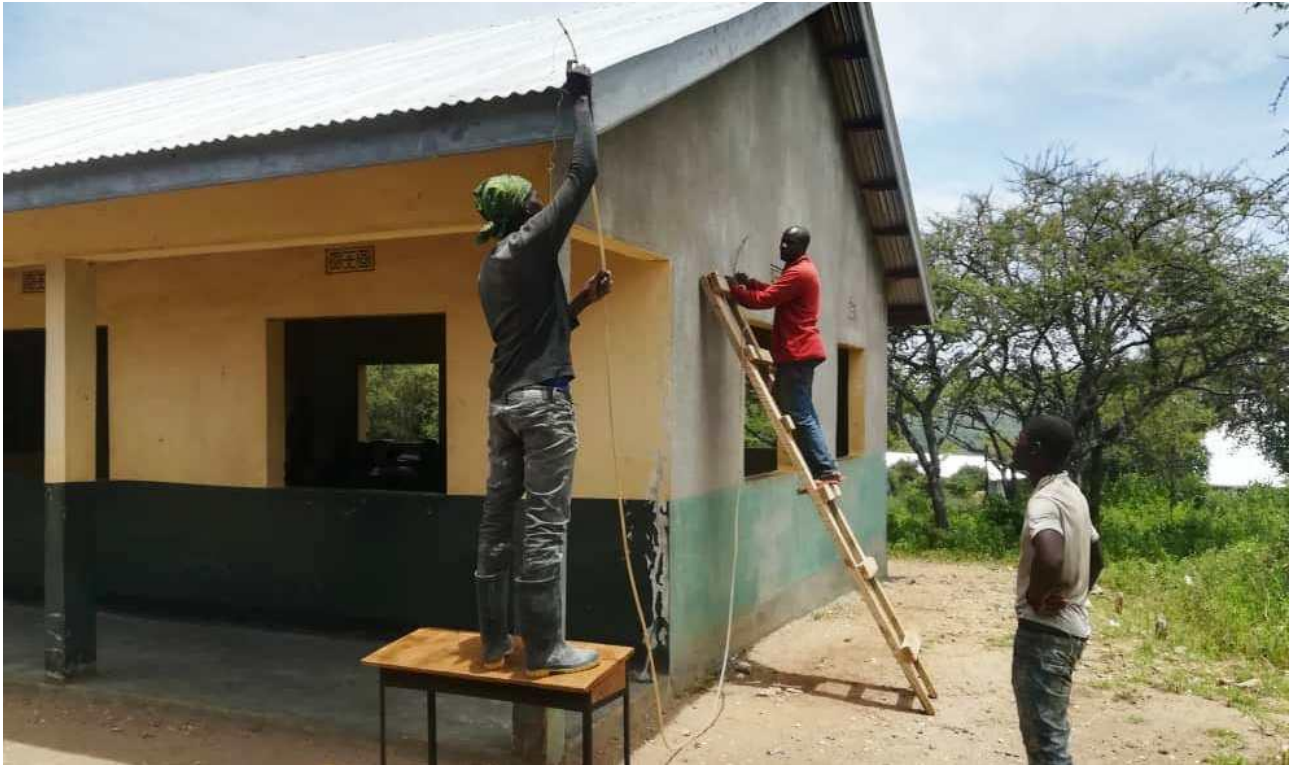
Abbildung 9: Handwerker ermitteln genauen Standort für Tankträger (Beton-Podest)
