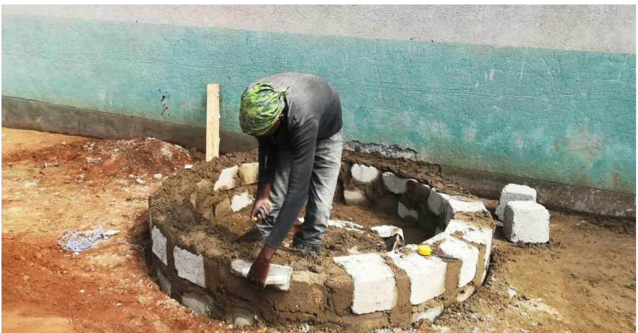
Abbildung 10: Stabile Fundamente als Tankträger aus Zementblocksteinen erstellt
