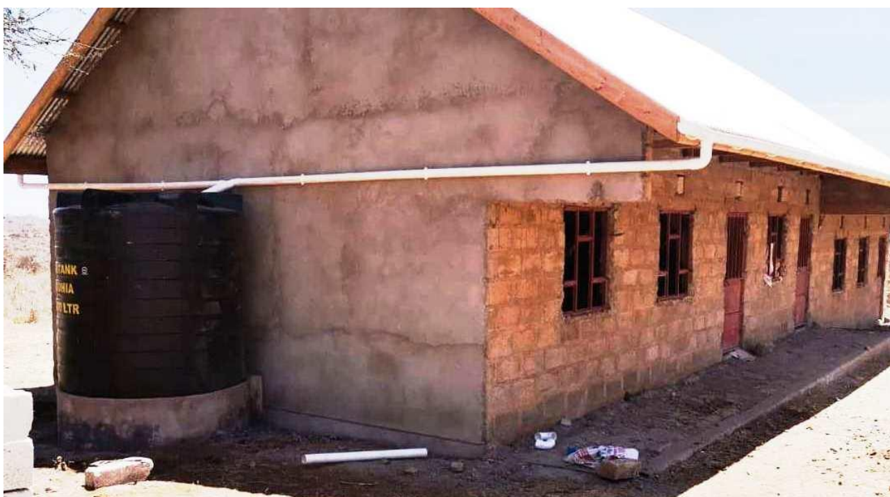
Abbildung 16: Drittes Schulgebäude mit ersten Aussenputz und installiertem Wassertank
