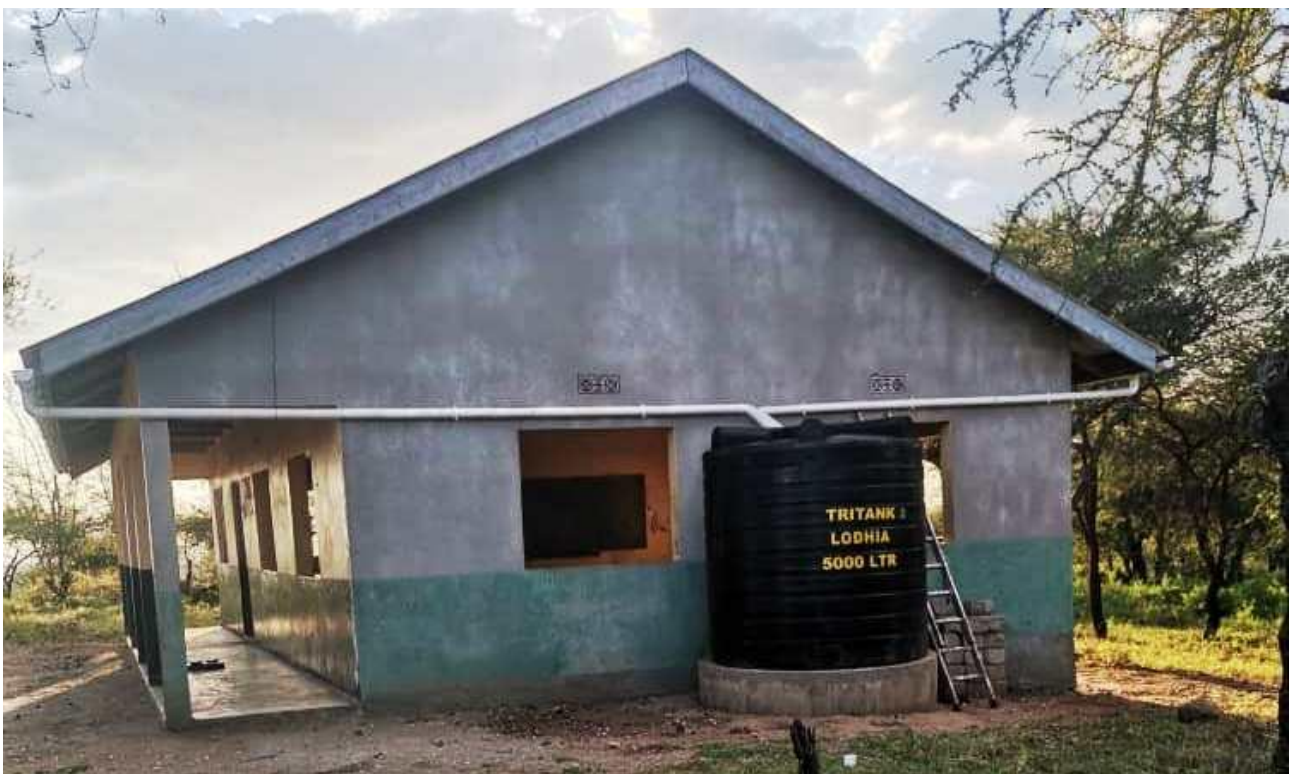
Abbildung 12: Wassertank an ersten Schulgebäude fertig installiert (1. Teilprojekt)
